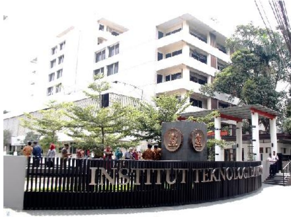
Gambar 3.21 Gedung Labolatorium Teknik 1
