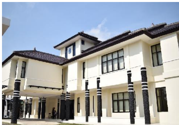
Gambar 3.33 Pembangunan Gedung ITB di Cirebon
