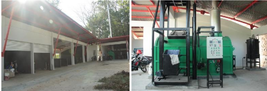
Gambar 3.39 Instalasi Pengolahan Sampah
