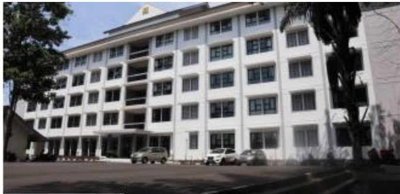
Gambar 10. Pembangunan Gedung Rusun Dosen ITB Jatinangor.
