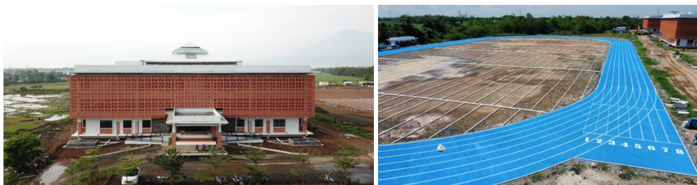
Gambar 15. Pekerjaan Pembangunan Gedung Multifungsi A Lanjutan (Kiri) dan Pekerjaan Sarana Olahraga Tahap 1 (Kanan).
