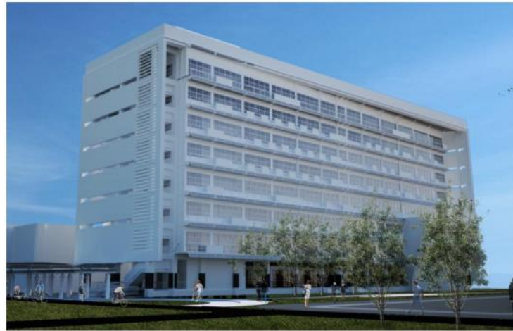
Gambar 7. Pembangunan Gedung LabTek XV (Prodi Kimia).
