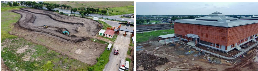
Gambar 14. Pekerjaan Pembangunan Embung dan Drainase ITB Cirebon (Kiri) dan Pekerjaan Lanjutan Gedung Multifungsi B Kampus ITB Cirebon (Kanan).
